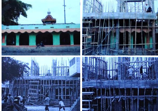
Gambar 2. Proses membangun di masjid berkubah dengan soko guru
