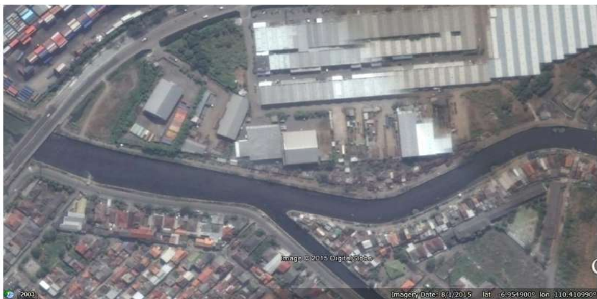
Gambar 4a: Kondisi site eksisting
