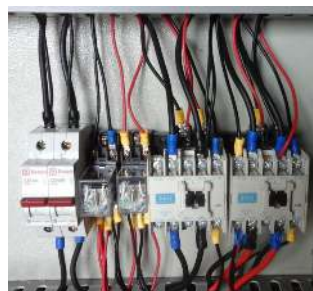
Gambar 4.12 Rangkaian utama ATS.
