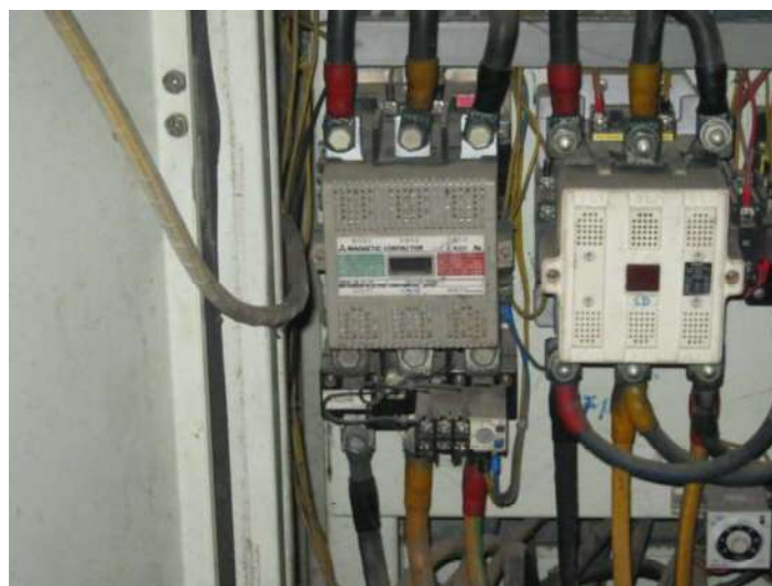
Gambar 3.12 Kontaktor motor pompa
